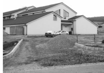
Bauarbeiten vor der Mehrzweckhalle in Eppe
