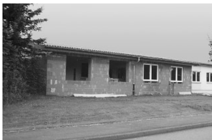
Anbau an die Mehrzweckhalle in Hillershausen
