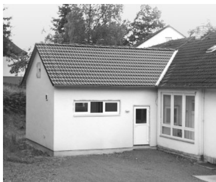
Küchenanbau am Dorfgemeinschaftshaus Goldhausen
